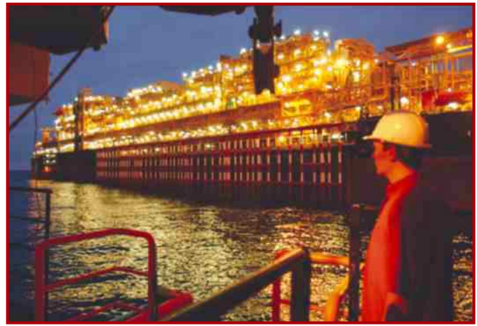
SITE OFFSHORE (LUMINAIRES APPLETON/ATX SUR LA PLATE-FORME TOTAL GIRASSOL)
